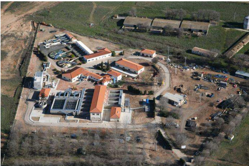
La antigua ETAP fue construida en dos fases, la primera en 1.981 para 300 l/seg y la segunda en 1.995, para 200 l/seg de capacidad de tratamiento teórico. Así, la planta ha tenido hasta septiembre de 2011 una capacidad de 500 l/seg. A partir de la entrada en funcionamiento de la ampliación, se dispone de otros 400 l/seg, con lo que la capacidad de tratamiento total sería de 900 l/seg.
