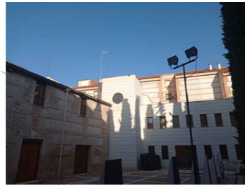
FOTO 10- EQUIPOS 2. TERRAZA INTERIOR.
