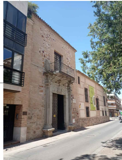
FOTO 7- FACHADA CALLE REYES
