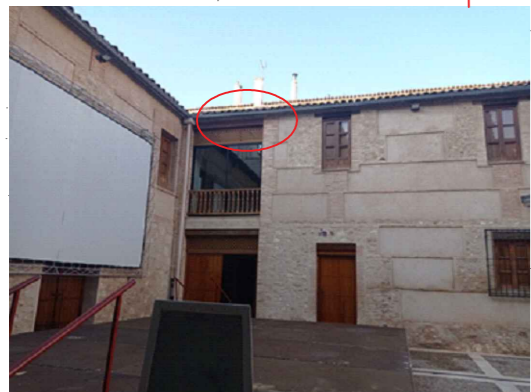
FOTO 8- EQUIPOS 1. CUBIERTA POSTERIOR
