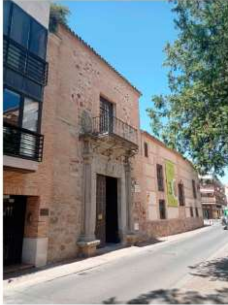
FOTO 7- FACHADA CALLE REYES
