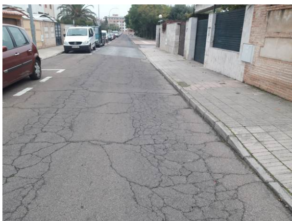
Calzada cuarteada y con descarnaduras
