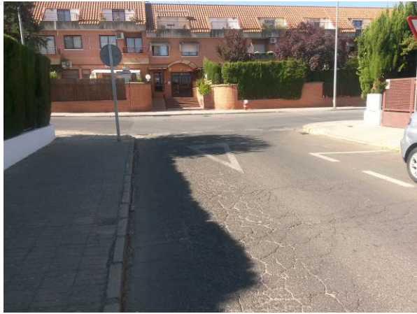
Calzada cuarteada y con descarnaduras
