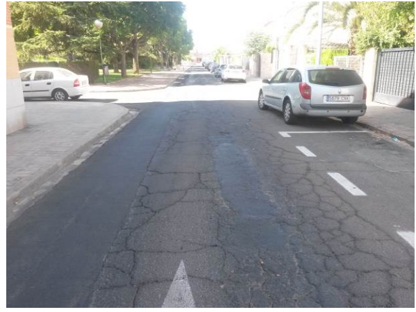
Calzada cuarteada y con descarnaduras
