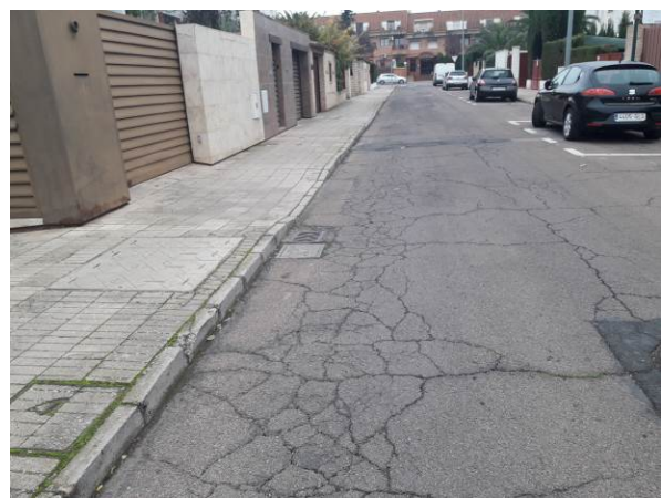
Calzada cuarteada y con descarnaduras
