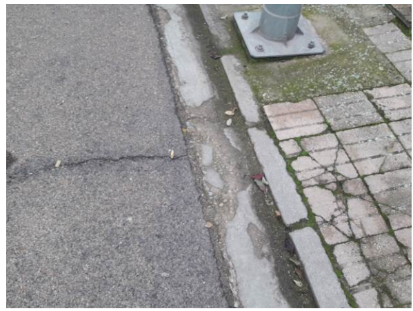
Rigola de hormigón in situ junto al bordillo
